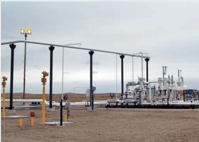
Planta turbocompresora de 10.000HP 2 millones m3/día. Rio Grande
