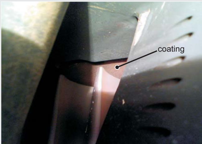
Fig. 5 - Estado del recubrimiento (coating) luego de 9.000 hs
